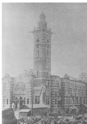
37-1. 関東大震災被災状況
