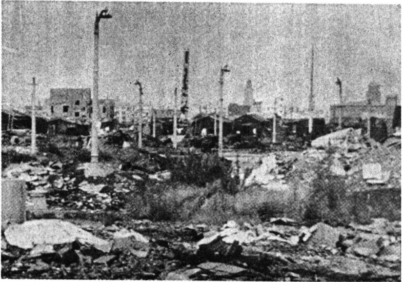
「バラック」が建ちだした県庁付近
