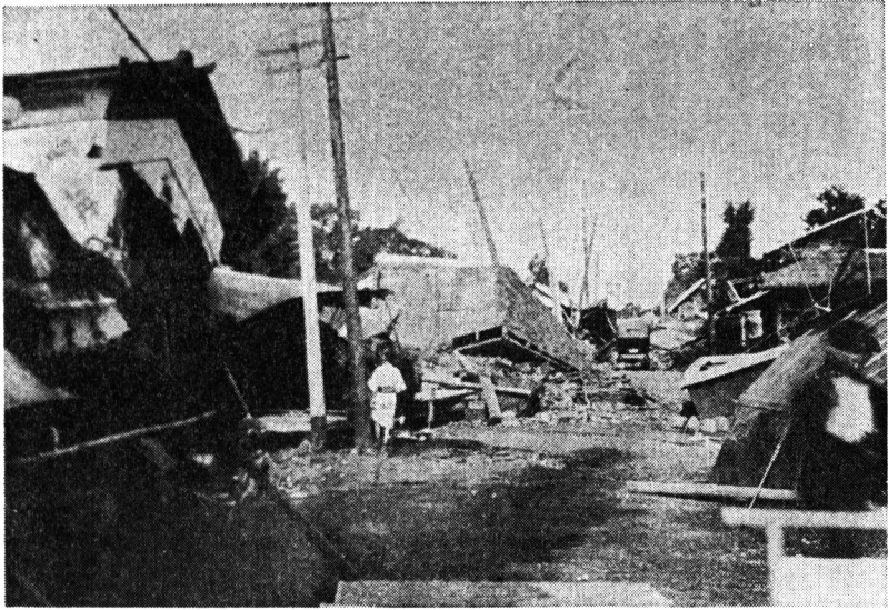
松田町松田停車場付近の状況
