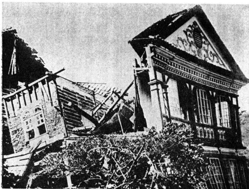
箱根宮ノ下付近の洋風建築
