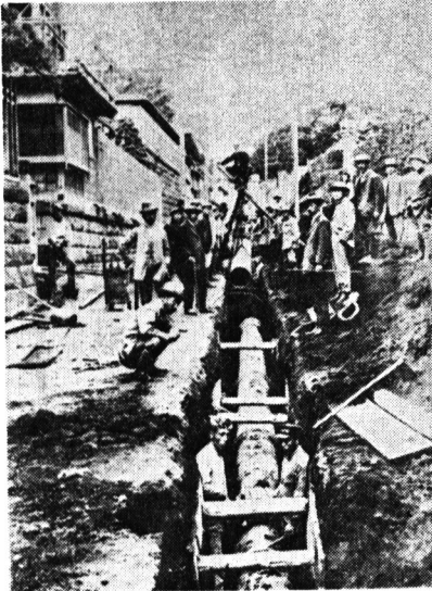
横浜市の水道管敷設工事 (1915年) 『横浜思い出のアルバム』から
