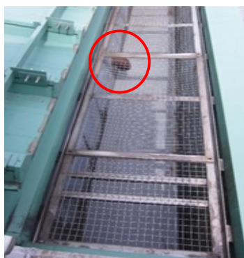
写真5：雨樋内のパイプ
