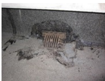
写真7：パイプの天井裏側出口
