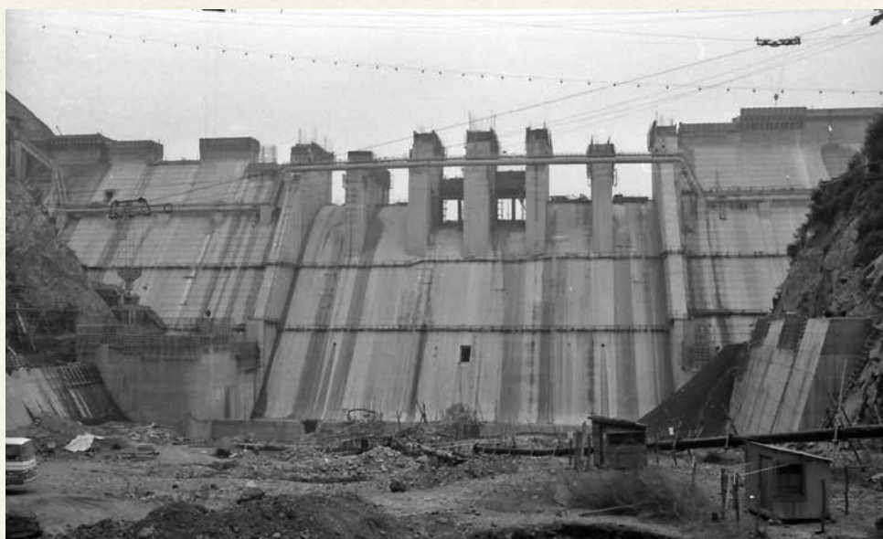
建設中の城山ダム (広報課撮影写真ID4199203832)
